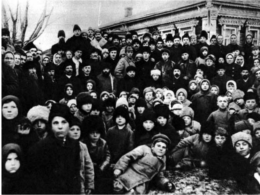
Lenin y Krupskaya con un grupo de campesinos en la aldea de Kashino, durante la apertura de una central eléctrica.
